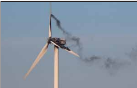
Lageerkundung bei brennender Windenergieanlage
